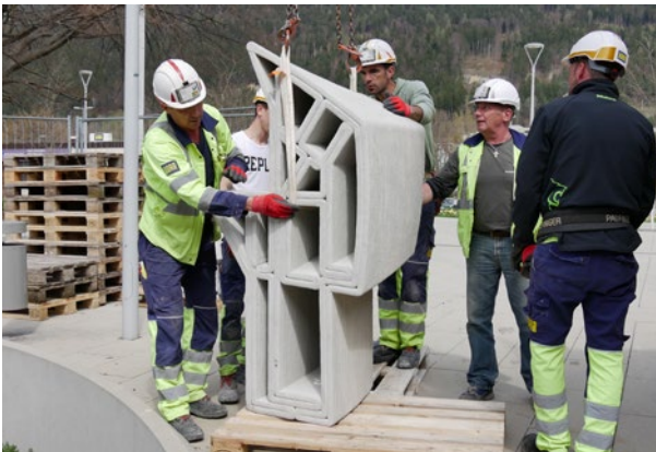
Abbildung 4: Jedes Bauteil wurde dem Lastfall entsprechend optimiert. Foto © Universität Innsbruck.
